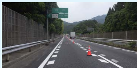
〔維持修繕工事〕
