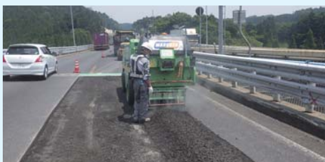
〔橋梁補修工事〕
