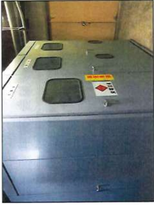
②電気室内変電設備
