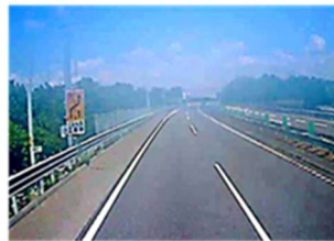
② 第2通行帯へ 1km先工事中
