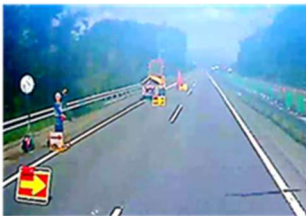
④ 誘導用人形看板と 案内標識車
