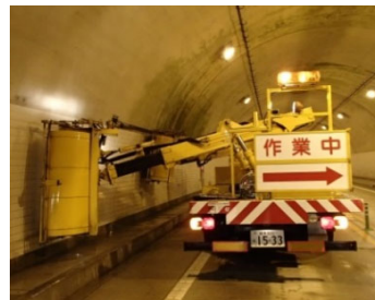
(トンネル内清掃)
