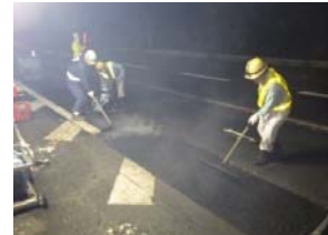
（舗装修繕工事）
