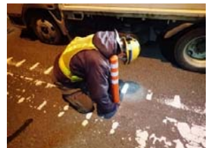
（道路附属物工事）
