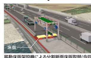
分割断面床版取替による交通規制（今回）※STEP1規制イメージ
