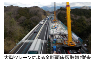
大型クレーンによる全断面床版取替（従来）
