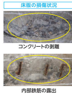
内部鉄筋の露出
