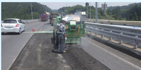
〔橋梁補修工事〕
