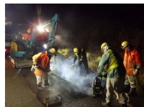
（舗装修繕工事）
