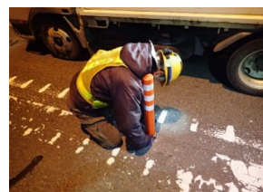
（道路附属物工事）
