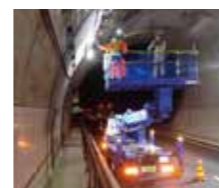
トンネル設備の点検
