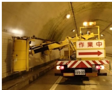
(トンネル内清掃)
