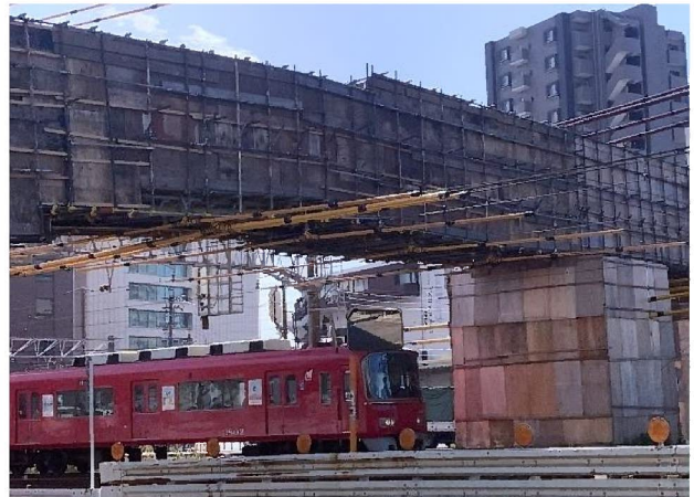
【高蔵こ線橋】足場設置状況
