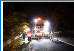
（舗装修繕工事）
