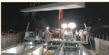
プレキャスト床版の施工
