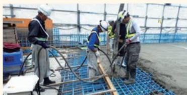
現場打ち床版の施工
