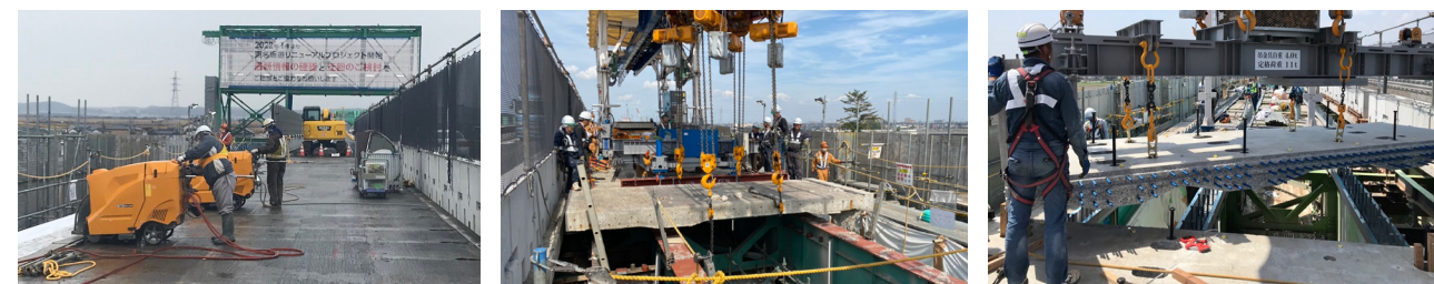
古い床版をカッターで切断
