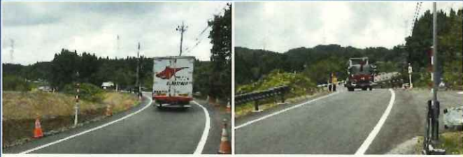
仮設道路の片側交互通行状況（小矢部市内山地区内）
