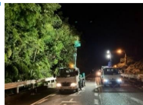
（維持修繕工事）
