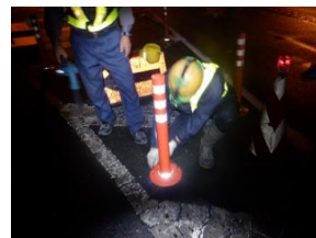
（道路附属物工事）
