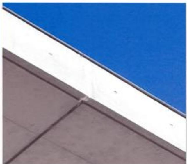
※ 庇全体に雨垂れなどの汚れや劣化により爆裂現象が発生している。
