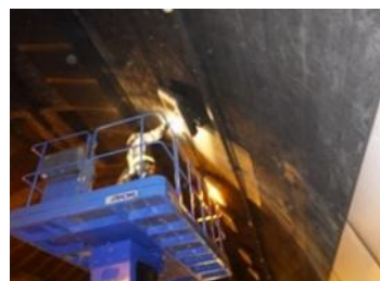
（道路施設の点検）
