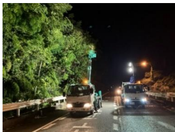
（維持修繕工事）
