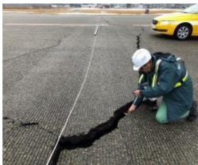
空港基本施設(滑走路等)の調査
