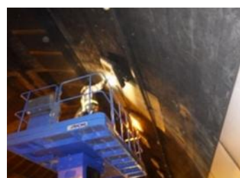
（道路施設の点検）
