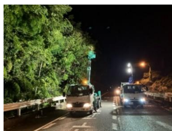
（維持修繕工事）
