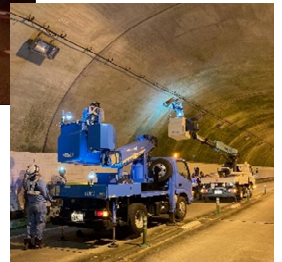
(トンネル照明更新)
